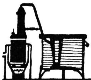
1834. Eisemaschine mit Äther vom Engländer Perkins gebaut. Eisemaschine durch Verdunstung von Ammoniak 1860 von dem franz. Ingenieur Carré erfunden, eine Erfindung von unberechenbarem Wert für die Nahrungsmittel-Industrie.
