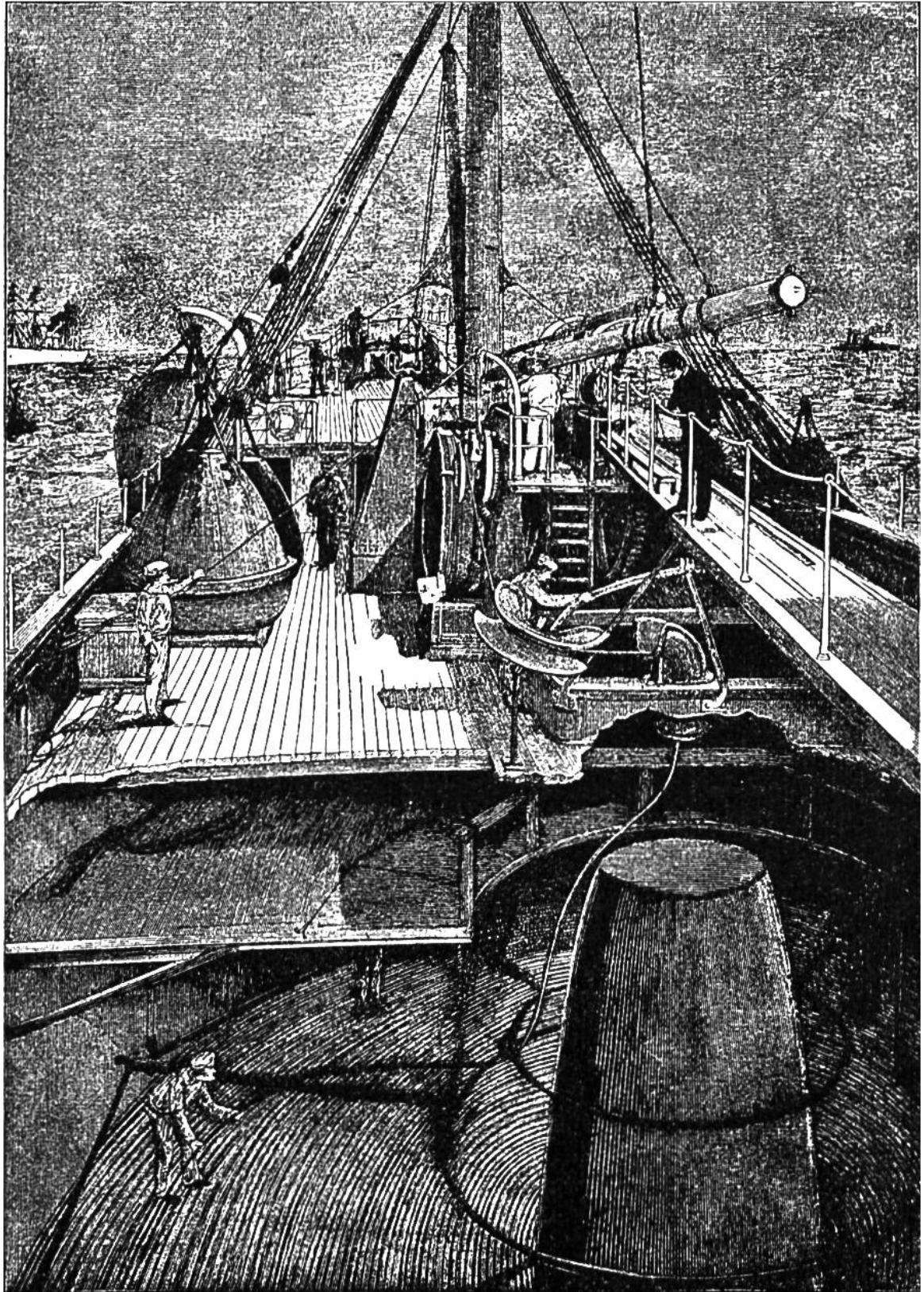
Innenraum eines Kabelfisches. Auf dem Boden unten im Schiff liegt das Kabel aufgerollt; durch eine Luke wird es auf Deck gezogen (wo es über verschiedene maschinelle Vorrichtungen läuft) und zuletzt durch eine sinnreiche Auslegemaschine auf den Meeresboden versenkt.
