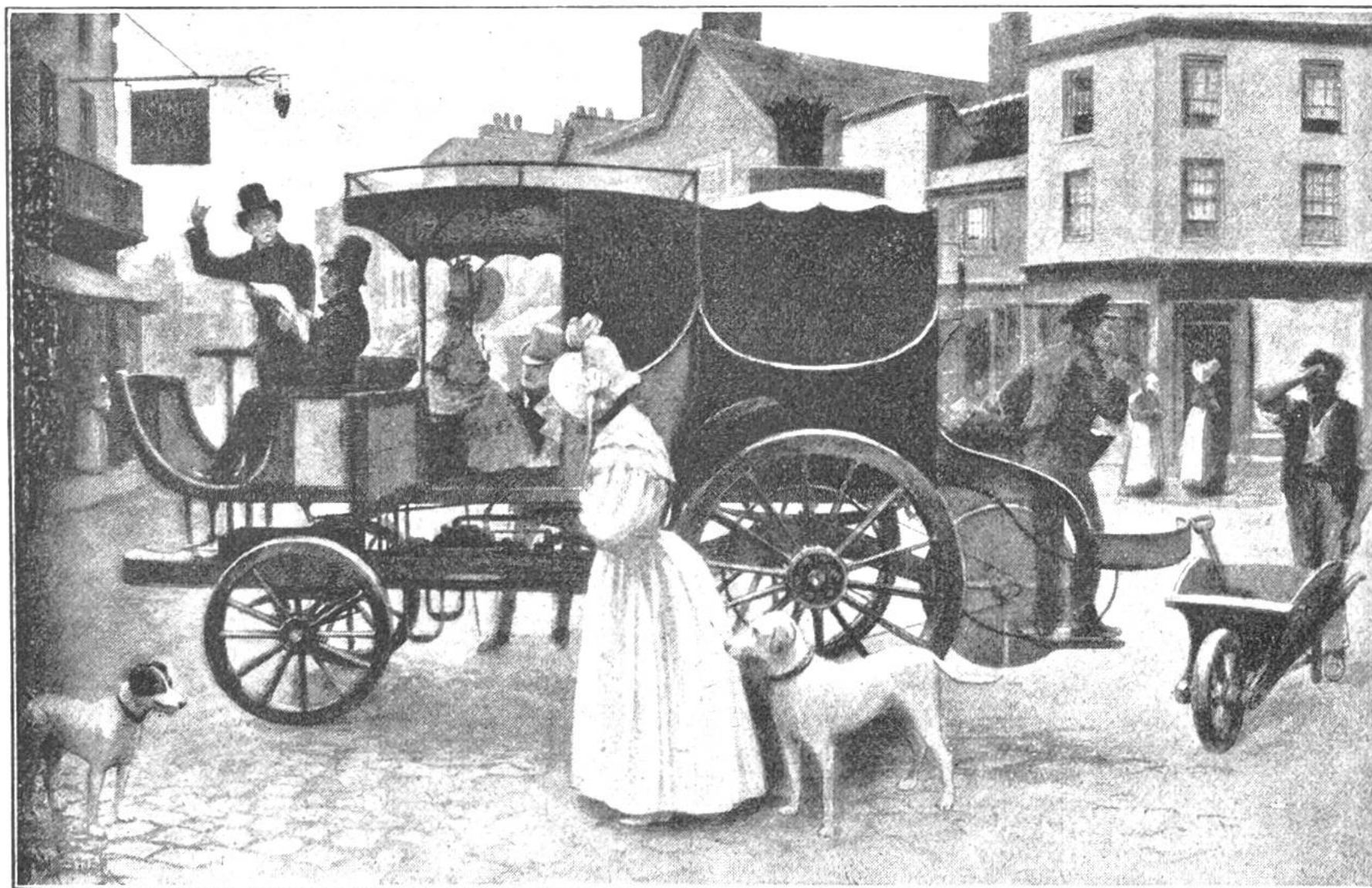
Die Verwendung von Dampfautos als Verkehrsmittel wurde vor nahezu hundert Jahren in England Mode. Der Erfindergeist schuf die merkwürdigsten Fahrzeuge; eines der zweckdienlichsten war der Wagen von Macerone und Squire (eines ehemaligen Arbeiters von Gurney). Dieser Wagen fuhr mit einer Geschwindigkeit von 30 km in der Stunde.
