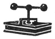
1780. Kopierpresse zum Abklatschen von Briefen auf nasses Briefpapier, unter Benutzung einer dicken Tinte, von dem Schoteten James Watt, dem Erfinder der modernen Dampfmaschine, erfunden und patentiert.
