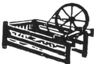
1767. James Hargreaves, ein armer englischer Spinner, baut nach mühseligen Studien die erste brauchbare Spinnmaschine (nach seiner Tochter „Jenny“-Maschine genannt). Die Maschine wurde von Arbeitern, die fürchten, durch sie brotlos zu werden, zerschlagen. Hargreaves starb im Elend.
