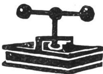
1780. Kopierpresse zum Abdrucken von Briefen auf nasses Briefpapier, unter Benutzung einer dicken Tinte, von dem Schotten James Watt, dem Erfinder der modernen Dampfmaschine, erfunden und patentiert.
