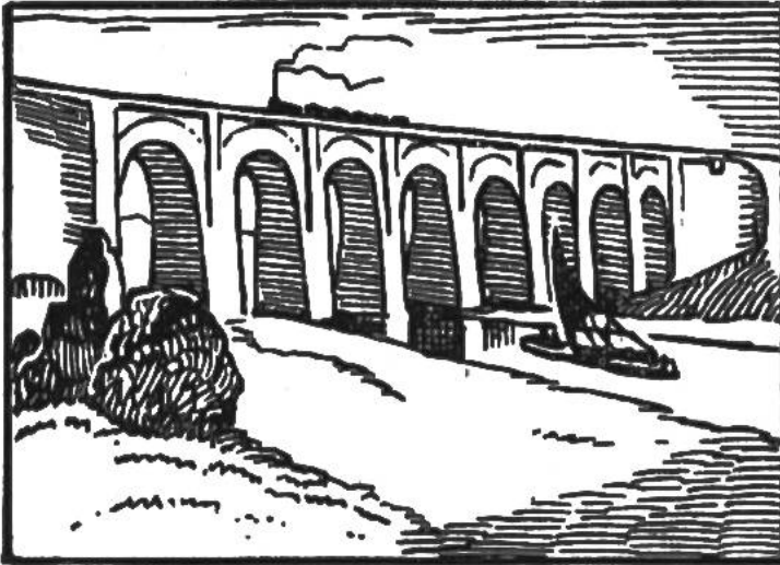
18. NEUN-BOGEN-VIADUKT AN DER BAHNSTRECKE LIVERPOOL-MANCHESTER.
