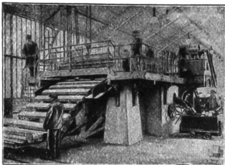
Elne Maschine, die 24 000 Holzblöcke für Strassenpflaster in einer Stunde zuschneidet.
