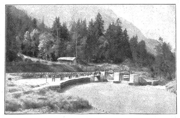
Wehranlage des Elektrizitätswerkes Kandergrund. Das Wasser wird von hier aus durch einen ca. 4200 Meter langen Zuleitungsstollen ins Wasserschloss geführt.
