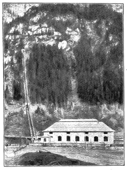
Druckleitung und Elektrizitätswerk Kandergrund, das dem Betrieb der Lötschbergbahn dient. Von dem 300 m über der Zentrale im Berginnern gelegenen Wasserschloss können 6 m³ Wasser pro Sekunde durch die Druckleitung auf die Turbinen abgelassen und damit 18,000 PS. erzeugt werden. ACHT MILLIONEN PFERDEKRÄFTE ZUR VERTEIDIGUNG DER SCHWEIZERISCHEN UNABHÄNGIGKEIT.
