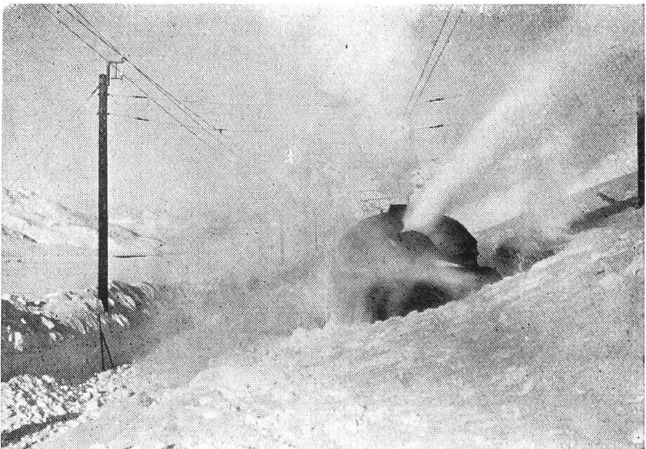
Schneesleudermaschine an der Arbeit.
