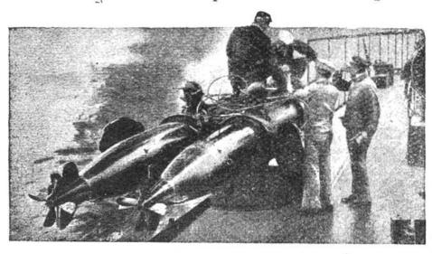
Auf einem Torpedoboot werden die Torpedos bereitgemacht. Jedes dieser 5-7 m langen und 54 cm dicken Geschosse enthält 150 kg Schiessbaumwolle und kostet rund 20,000 Fr. Es wird durch die Schiffsschrauben, die hinten deutlich sichtbar sind, mit einer Stundengeschwindigkeit von etwa
