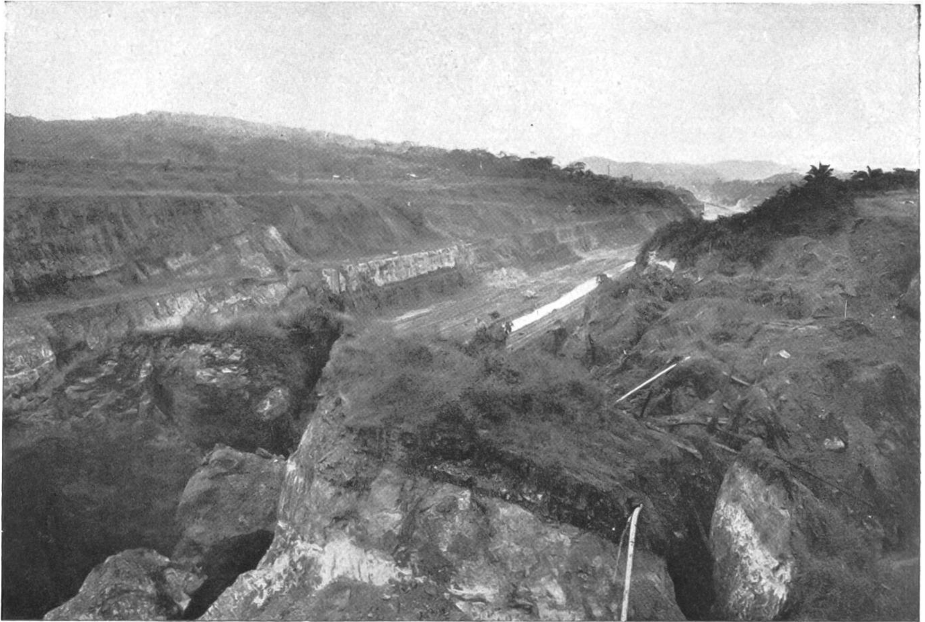
Der Culebradurchstich. Das Bild lässt erkennen, welch gewaltige Massen Erde hier beseitigt werden mussten, um dem Kanal Platz zu machen.
