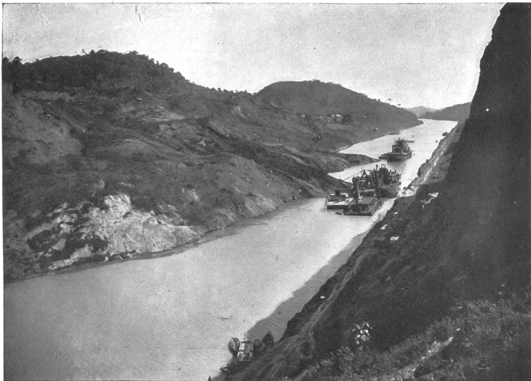
Der Culebra-Durchstich kurz vor der Vollendung. Baggermaschinen räumen nachgerutschte Erde weg.
