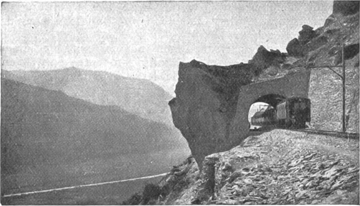
Viktoriatunnel auf der Walliser Seite der Lötschbergbahn; von den Ingenieuren so benannt nach dem links daneben befindlichen Felsen, dessen Profil eine erstaunliche Ähnlichkeit mit der verstorbenen Königin Viktoria von England hat; der obere Teil gleicht der von der Königin getragenen Krone.
