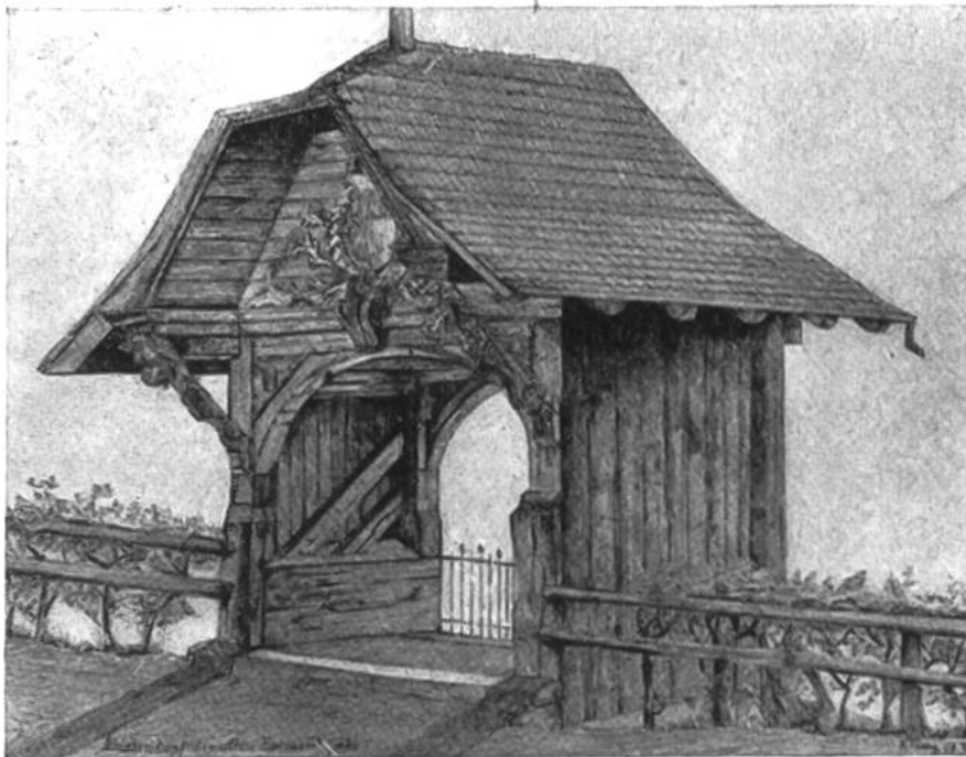
Brückenkopf an der Sihl beim Landesmuseum in Zürich.
