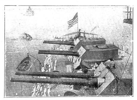
Die Geschütztürme der modernen Panzerschiffe sind nebeneinander, aber auf verschiedenen erhöhten Terrassen angeordnet, so dass jeder Turm mit seinen zwei Geschützen sich vollständig um seine Achse drehen kann.
