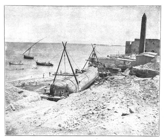
Die Londoner Cleopatra-Nadel ist zu einem Zylinder fertig verpackt und bereit, in das Meer gerollt zu werden. Rechts hinten auf dem Bilde sieht man die jetzt in Paris befindliche Cleopatra-Nadel
