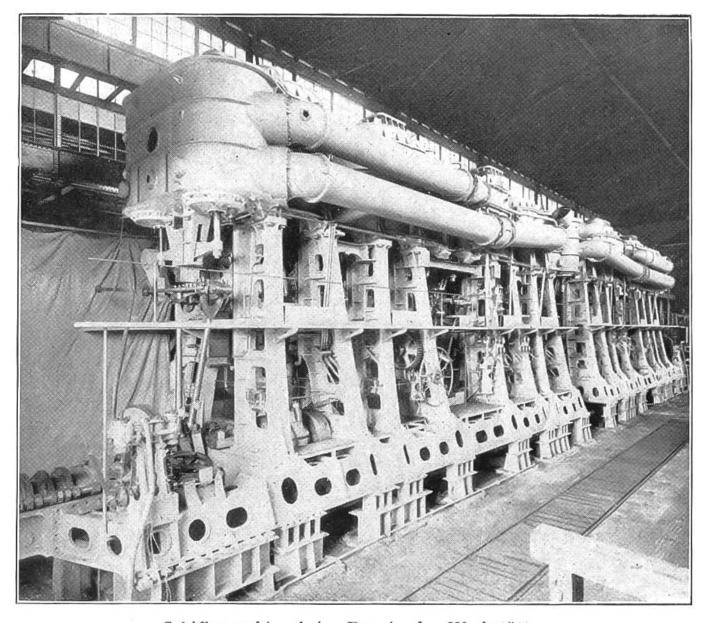
Schiffsmaschine beim Bau in der Werkstätte.
