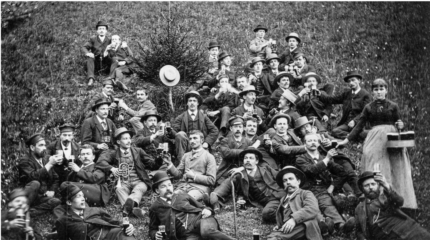
Pflege des Betriebsklimas in der Belle Epoque: Ab und zu wurde ein «Blauer Montag» eingeschaltet. Hier eine Abteilung der Hasler-Belegschaft beim Picknick im Zehndermätteli (Montag, 18. Mai 1891).
