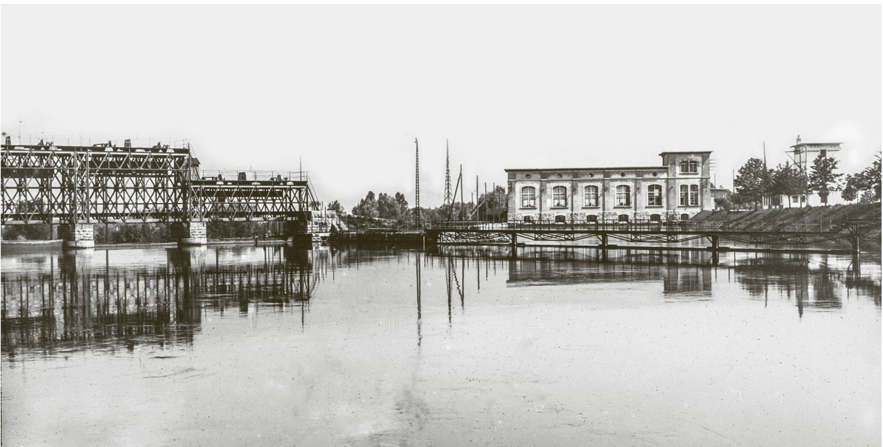
Das Kraftwerk Hagneck mit dem Stauwehr links und dem Turbinenhaus rechts um 1925.
