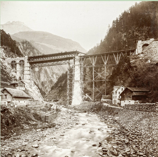
Die Kerstelenbachbrücke auf der Gotthard-Nordrampe im Bau 1881/82.
