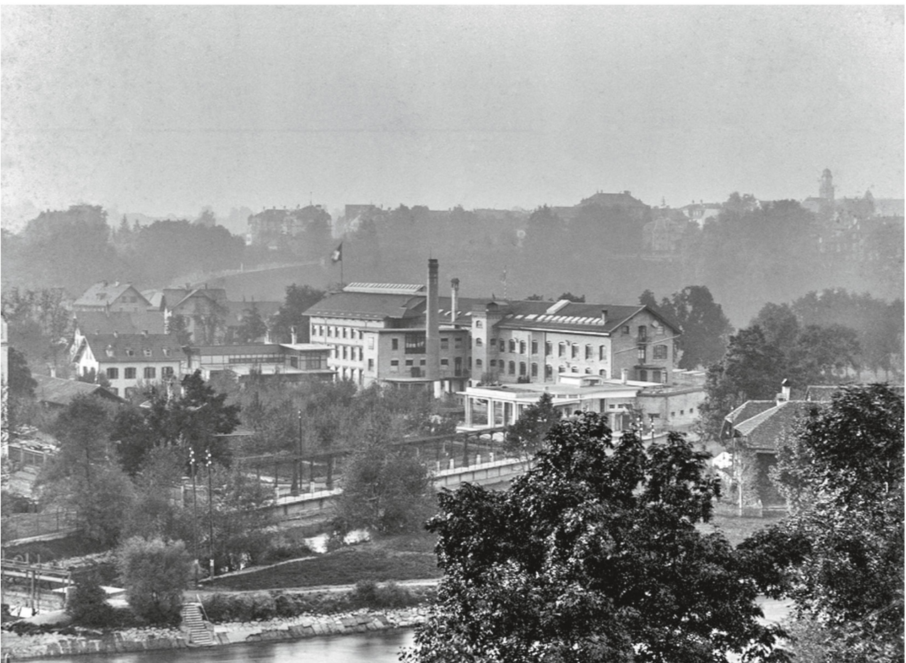
Das Postkartenbild zeigt die «Swan Brand Knitting Works Switzerland» mit der Aare im Vordergrund. Zwischen Fabrik und Aare sind Pavillon und überdeckte Wandelhalle zu sehen.
