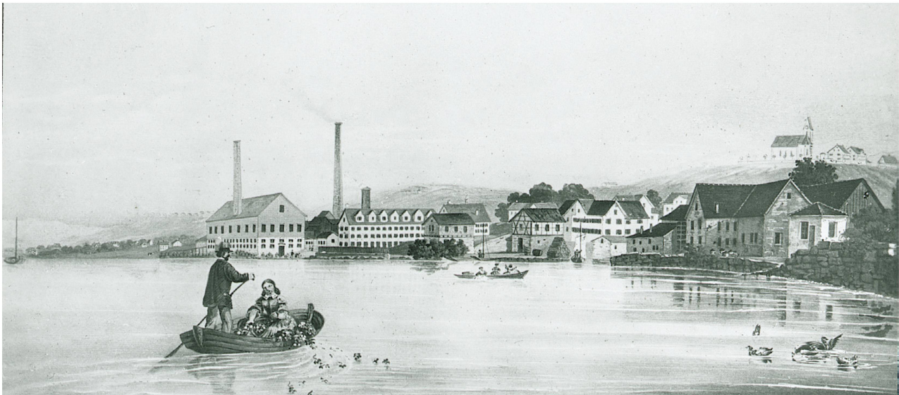
Erweiterte Fabrik mit neuer Bleikammer und Hochkamin, 1862. Der viereckige Hochkamin verbesserte den Luftzug im Schwefelofen.
