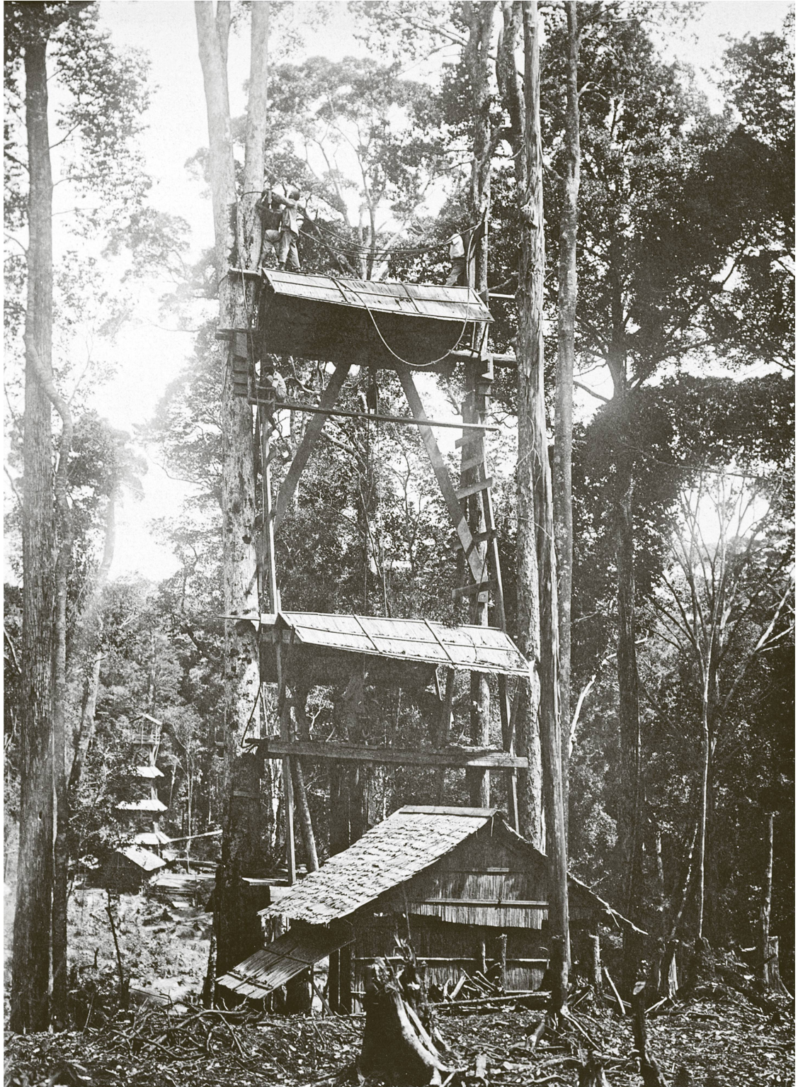
Von Wolfgang Leupold auf Borneo betreute Handbohrung. Als Bohrturm dienten zwei noch lebende Bäume, die mittels Balken verbunden wurden. Ziel dieser Bohrung war es, einen auf 300 Meter Tiefe gefundenen Erdölhorizont zu untersuchen. Im Hintergrund ist eine maschinelle Bohrung zu erkennen.
