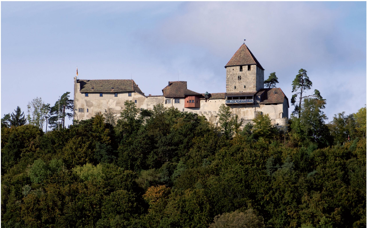
Die Burg Hohenklingen konnte dank der Windler-Stiftung umfassend renoviert werden.
