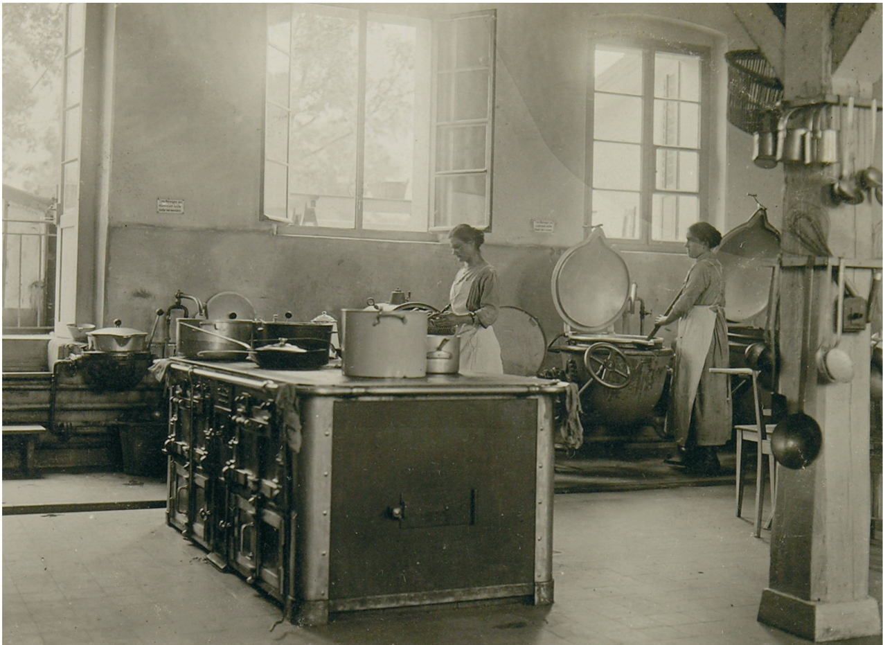
Die Küche des ersten, im Januar 1918 eröffneten Wohlfahrthauses der Maschinenfabrik Bühler in Uzwil.
