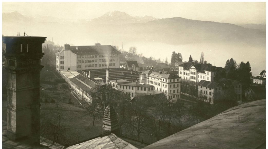
Das Fabrikareal an der Hofstrasse mit dem neu erstellten Hochbau, 1920.
