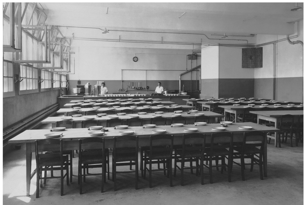
Alte Betriebskantine an der Hofstrasse.
