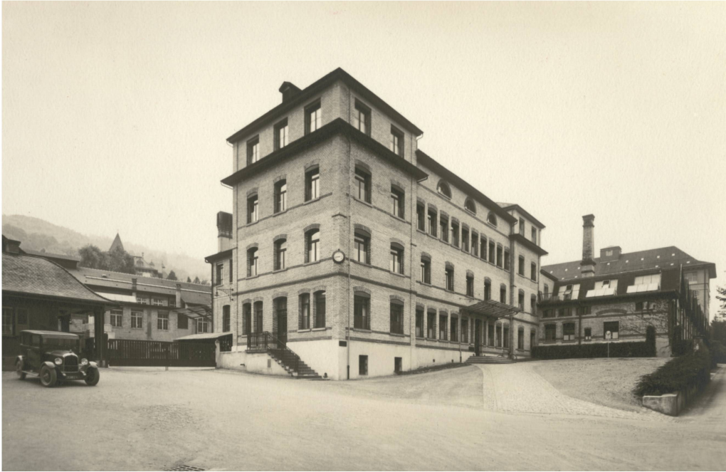
Das Theilerhaus nach einer weiteren Aufstockung und mit einem neuen Haupteingang in der Mitte, um 1918.
