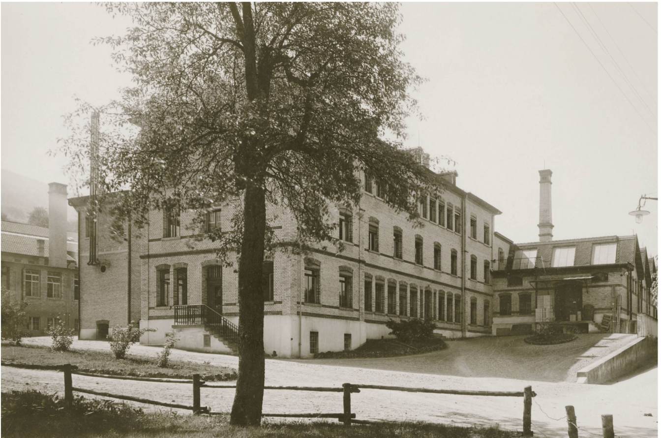
Das Theilerhaus nach der ersten Aufstockung, rechts daneben die Shedhallen, um 1914.
