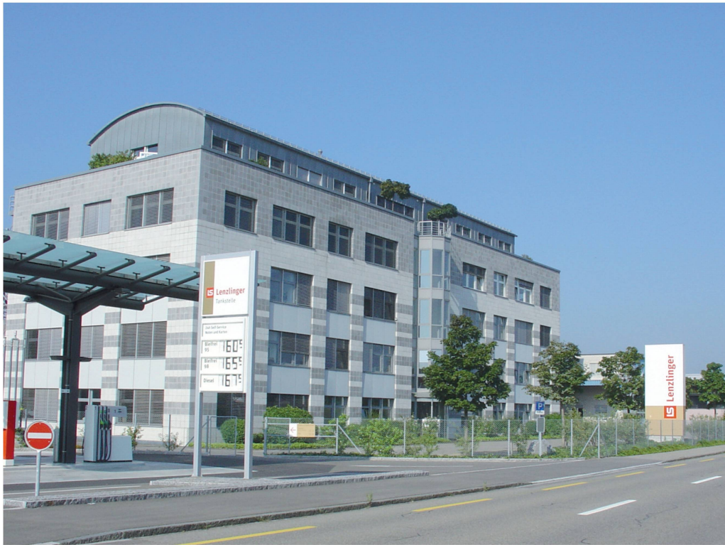
Der neue Lenzlinger-Firmenhauptsitz in Nänikon wurde 1991 bezogen, aktuelle Aufnahme.
