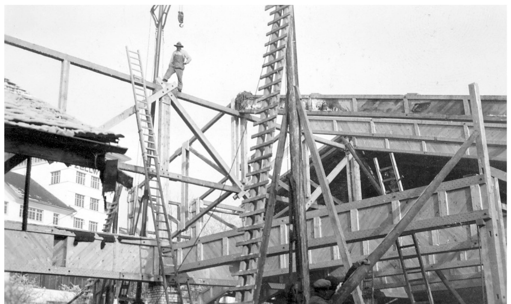
Wiederaufbau der Halle für die Parkettfabrikation nach dem Brand von 1945.
