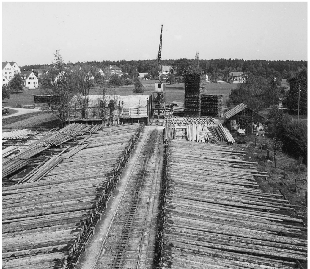
Die Imprägnieranlage für Telefonstangen in den 1930er Jahren.
