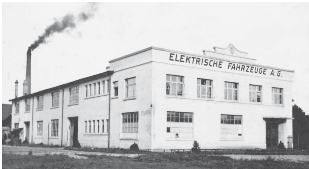
Als rauchende Schloten noch Zeichen für wirtschaftlichen Erfolg waren: Die neue Halle der EFAG auf dem Gelände der Akkumulatorenfabrik Oerlikon, um 1930.
