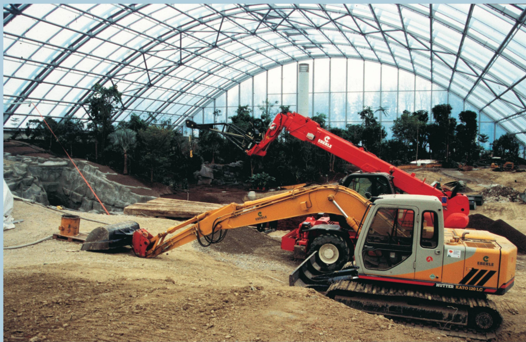
Die Halle für den Masoala Regenwald im Bau, 2002.
