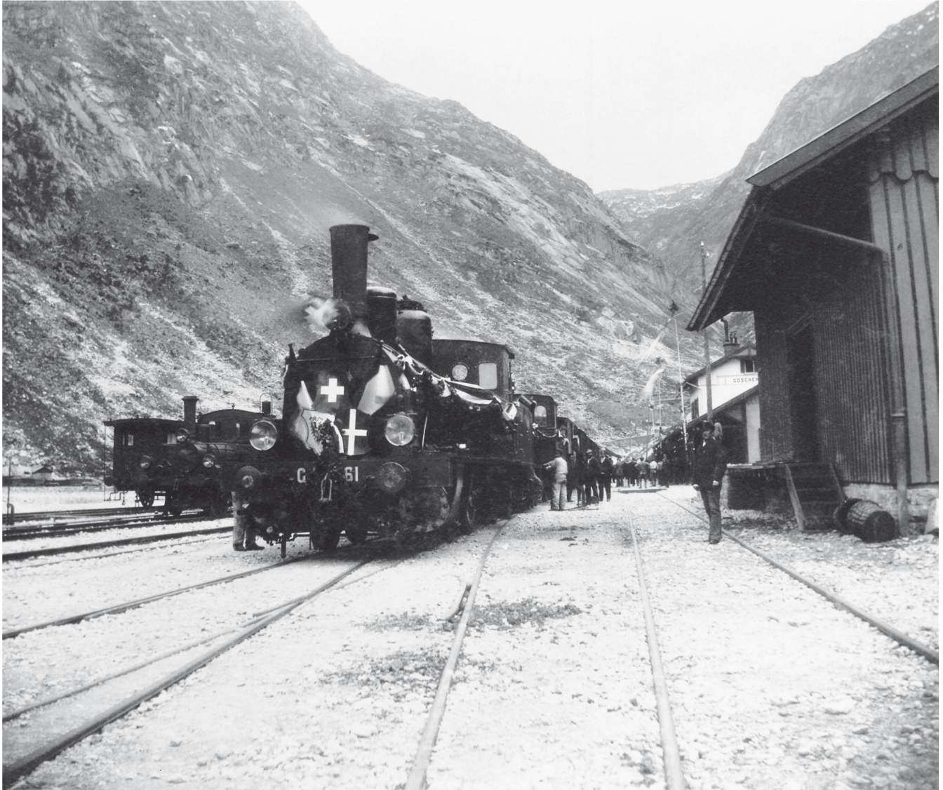
Der offizielle Eröffnungszug legte auf der Rückfahrt von Mailand am 25. Mai 1882 in Göschenen einen Zwischenhalt ein. Links der beiden geschmückten Lokomotiven ist eine der kleinen Zweiachsmaschinen zu sehen, die vom 1. Januar 1882 an die Post (verbindungs)-Züge durch den Tunnel gefahren haben.
