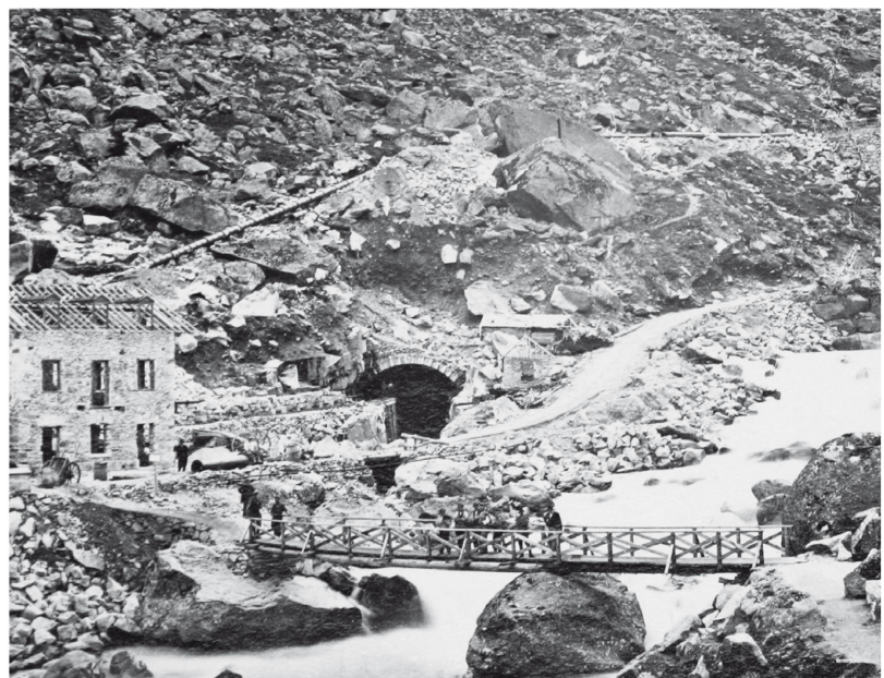
Göschenen: Tunnelportal und Druckleitung. Links Bürohaus im Bau. Im Vordergrund ein provisorischer Zu- gangssteig über die Reuss.
