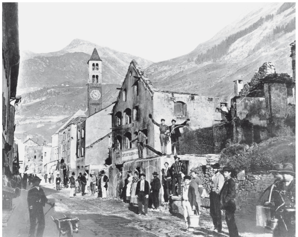
Am 17. September 1877 wurde das Dorf Airolo ein Raub der Flammen. Die Baustelle blieb verschont, nicht aber die Belegschaft. Leid und Not kannten kaum mehr Grenzen.
