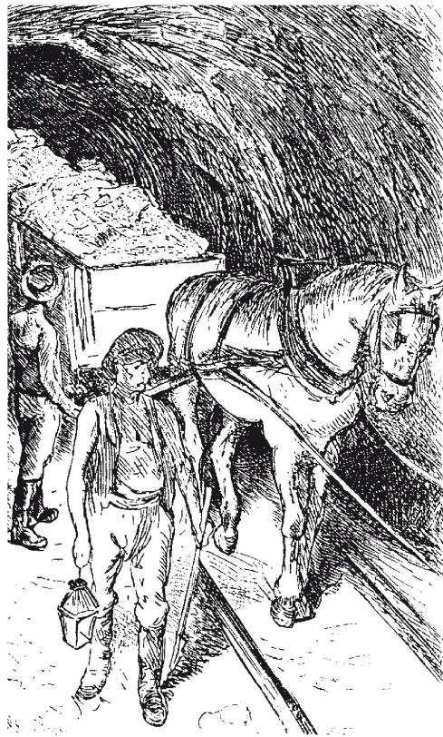
Die Druckpartie bei Km 2,8 von Göschenen erschwerte den Betrieb. Hinter den Holzeinbauten kamen nur mehr Pferde zum Zug.
