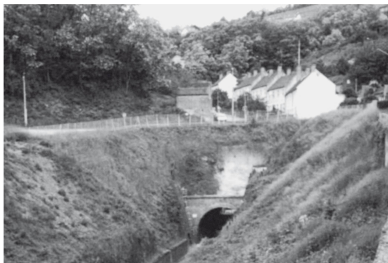
Der längste, von Louis Favre bis 1872 aufgefahrene Tunnel war jener von Le Creusot, 934 m lang und doppelspurig.
