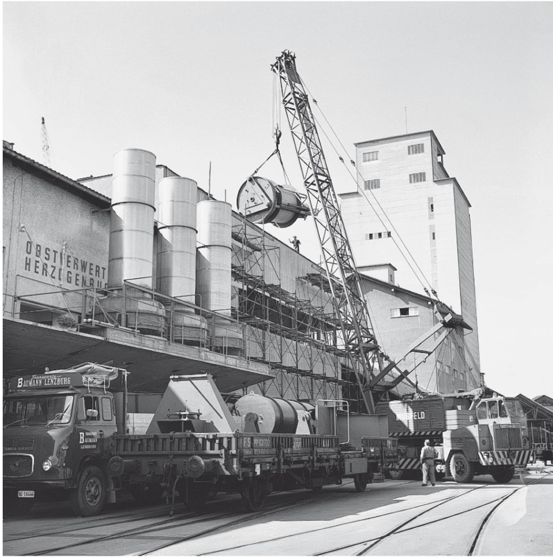
Der Presskorb einer Universal-Früchtepresse HP 5000 schwebt durch die Lüfte, um bei der Obstverwertung Herzogenbuchsee eingebaut zu werden. Bild von 1966.
