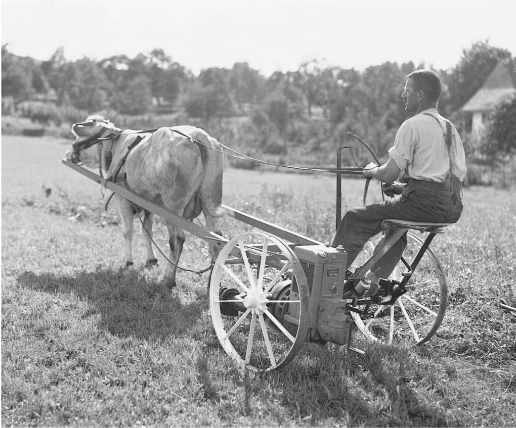
Gespannmähmaschine mit Aufbaumotor, 1934.
