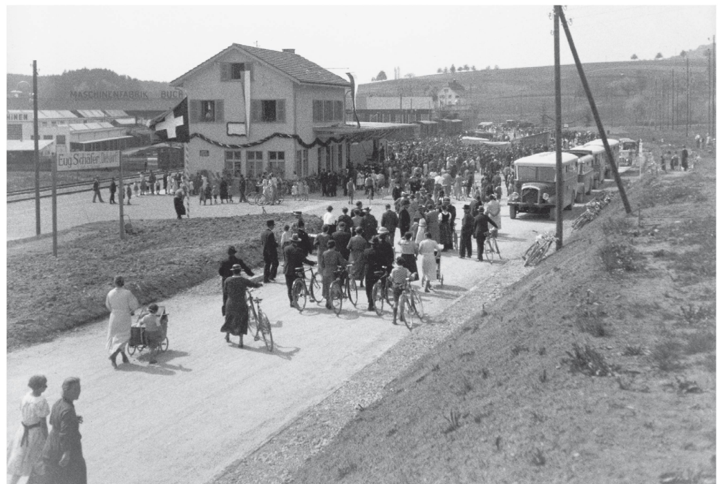
Einweihung des neuen Stationsgebäudes Niederweningen vor dem Bucher-Fabrikareal, 1938.
