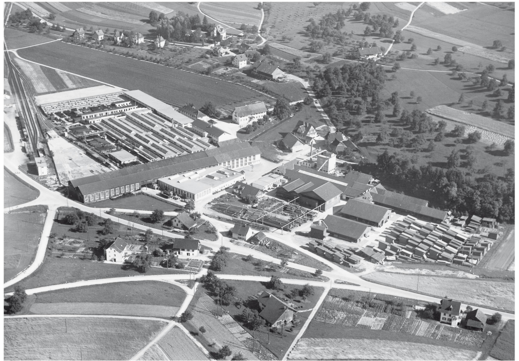
Luftaufnahme des Fabrikareals von Nordwesten, 1948.
