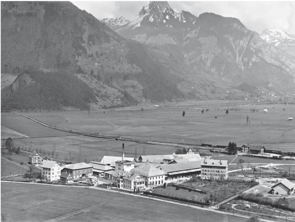
Die Trockenlegung der Linthebene schuf Raum für die Industrialisierung. Fast etwas einsam stand das Eternitwerk, das 1903 in einer alten Spinnerei eingerichtet wurde, neben dem Bahnhof von Niederurnen.
