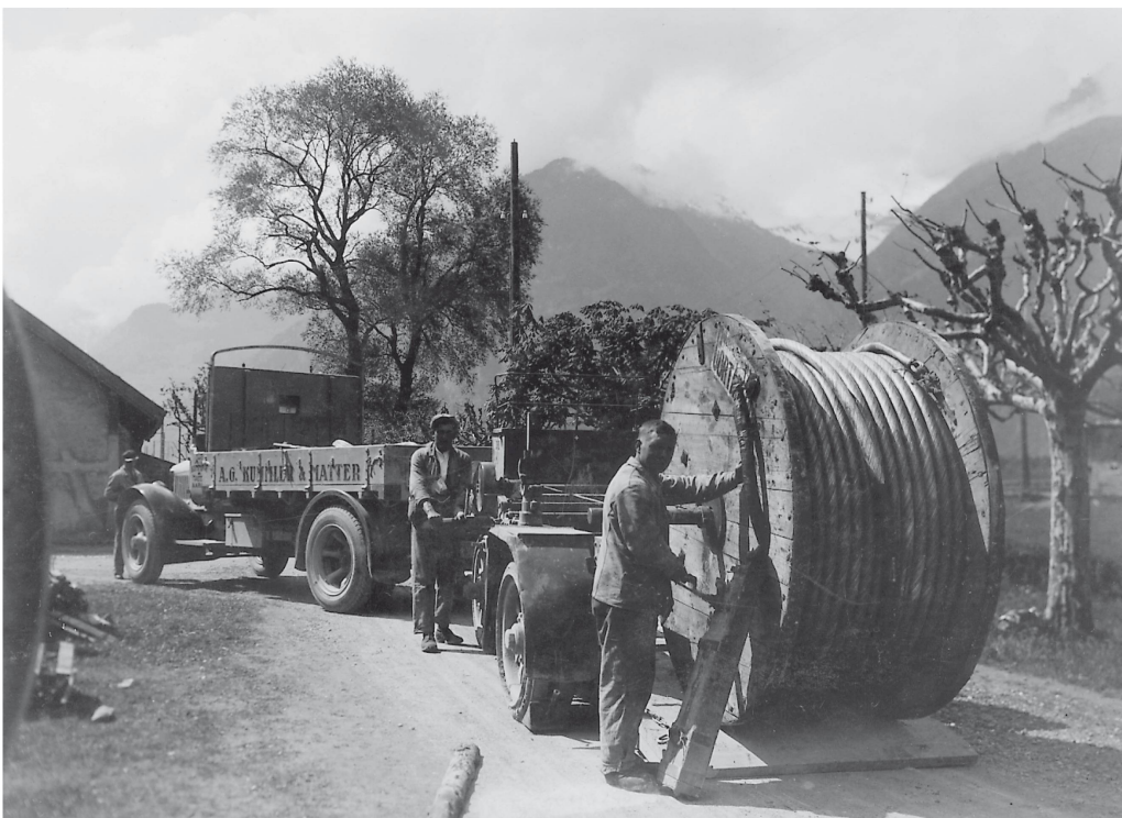
Abladen der Kabelrollen
