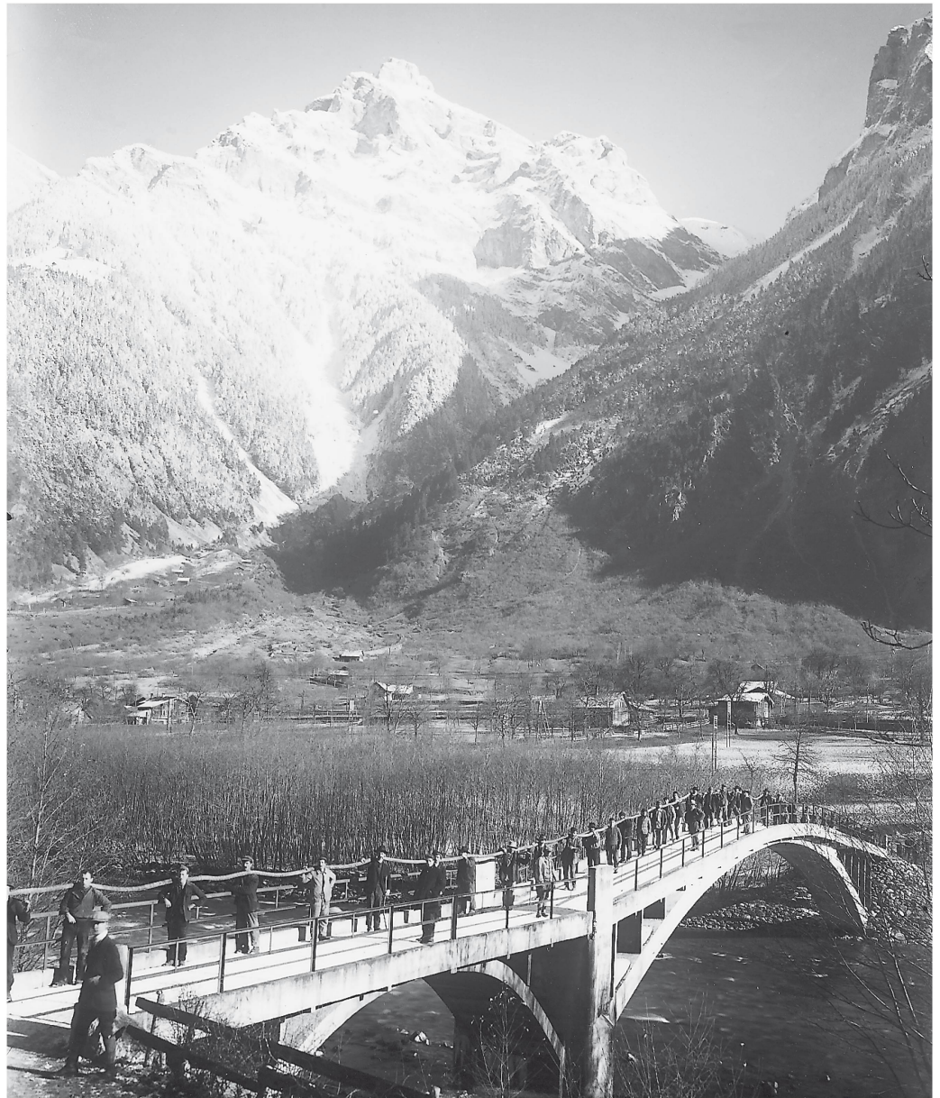
Kabeltransport über den Rhein...
