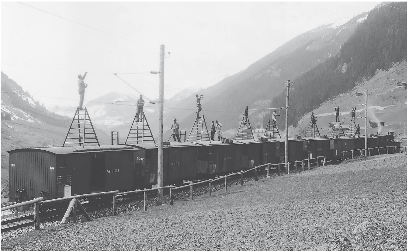
Fahrleitungsbau Rhätische Bahn, 1921/22 Reichenau-Disentis nach der Station Sumvitg-Compadials
