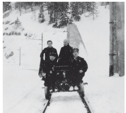
Kummeler mit Bahnmeister, Tochter Elsa und Sohn Alfred oberhalb Station Muot, Schutzpfeiler aus Beton
