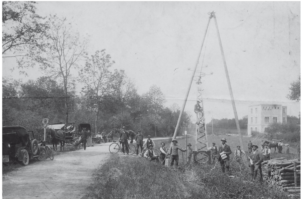
Leitungsbau Kumm- ler & Matter in Deutsch- land: Aufstellen eines Gittermastes
