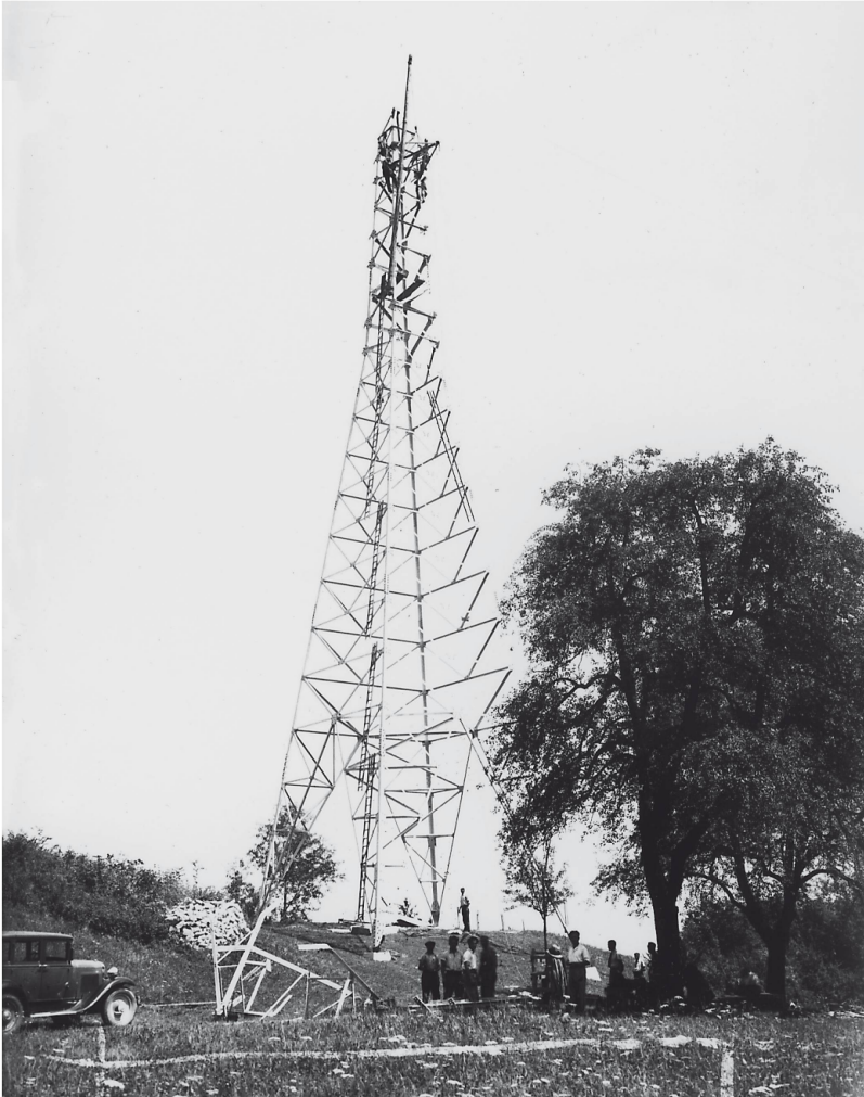
Hochspannungs-Leitungsbau durch Kumm- ler & Matter um 1914: Setzen der Masten
