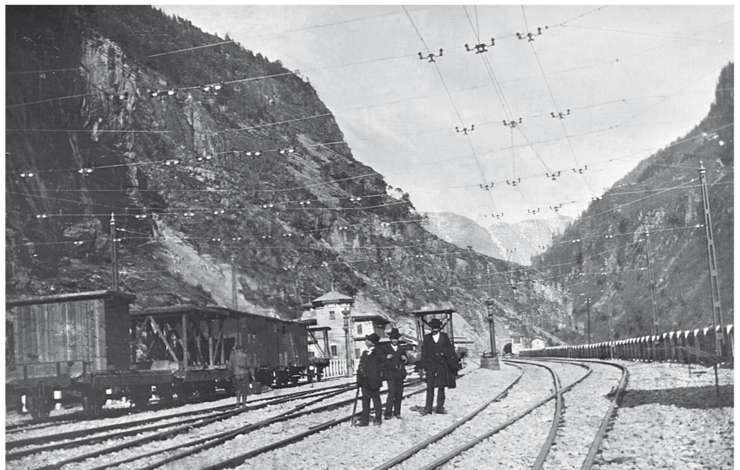
Kummler vorne mit Stock bei der Besichtigung der Leitungen in der Station Iselle di Trasquera
