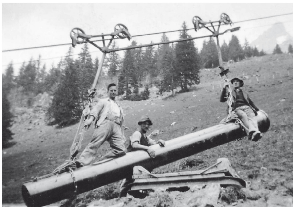
Karl Garaventa, rechts auf dem Rohr sitzend, half Dritten, hier der Nidwaldner Firma Odermatt, bei Transportaufgaben: Druckleitungsrohre für das Kraftwerk des Klosters Engelberg. Im Vordergrund ist das Gestell einer Lore zu erkennen, die das Rohrstück auf einem Hilfsgleis herangerollt hatte.
