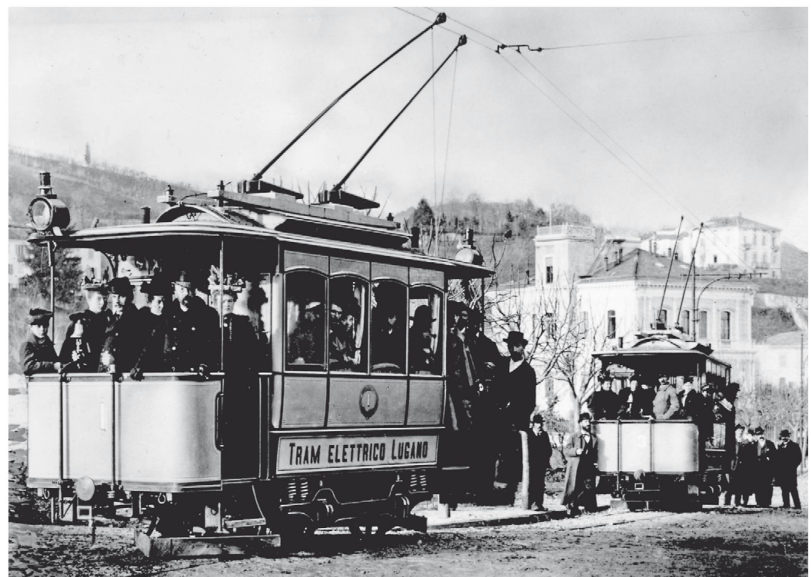
Drehstrom-Strassenbahn Lugano mit doppelpoliger Fahrleitung, Eröffnung 1896.
