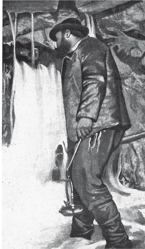
Ingenieur bei der Kontrolle einer der Heisswasser-Einbrüche im Simplontunnel.
