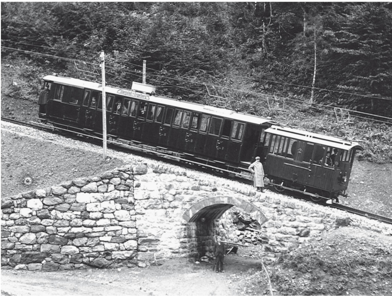
Zug der mit Drehstrom (dreiphasigem Wechselstrom) betriebenen Stansstad-Engelberg-Bahn über einem Wegdurchlass auf der Zahnstangensrecke zwischen Obermatt und Ghärst, um 1899.
