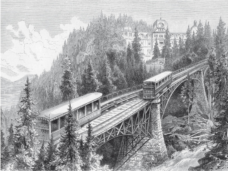
Giessbachbahn mit Hotel Giessbach. Bahn und Brücke wurden 1879 von der Maschinenfabrik Aarau im Auftrag der Hoteliersfamilie erbaut. Erstmals verwirklichte Roman Abt hier seine automatische Seilbahn-Ausweiche.
