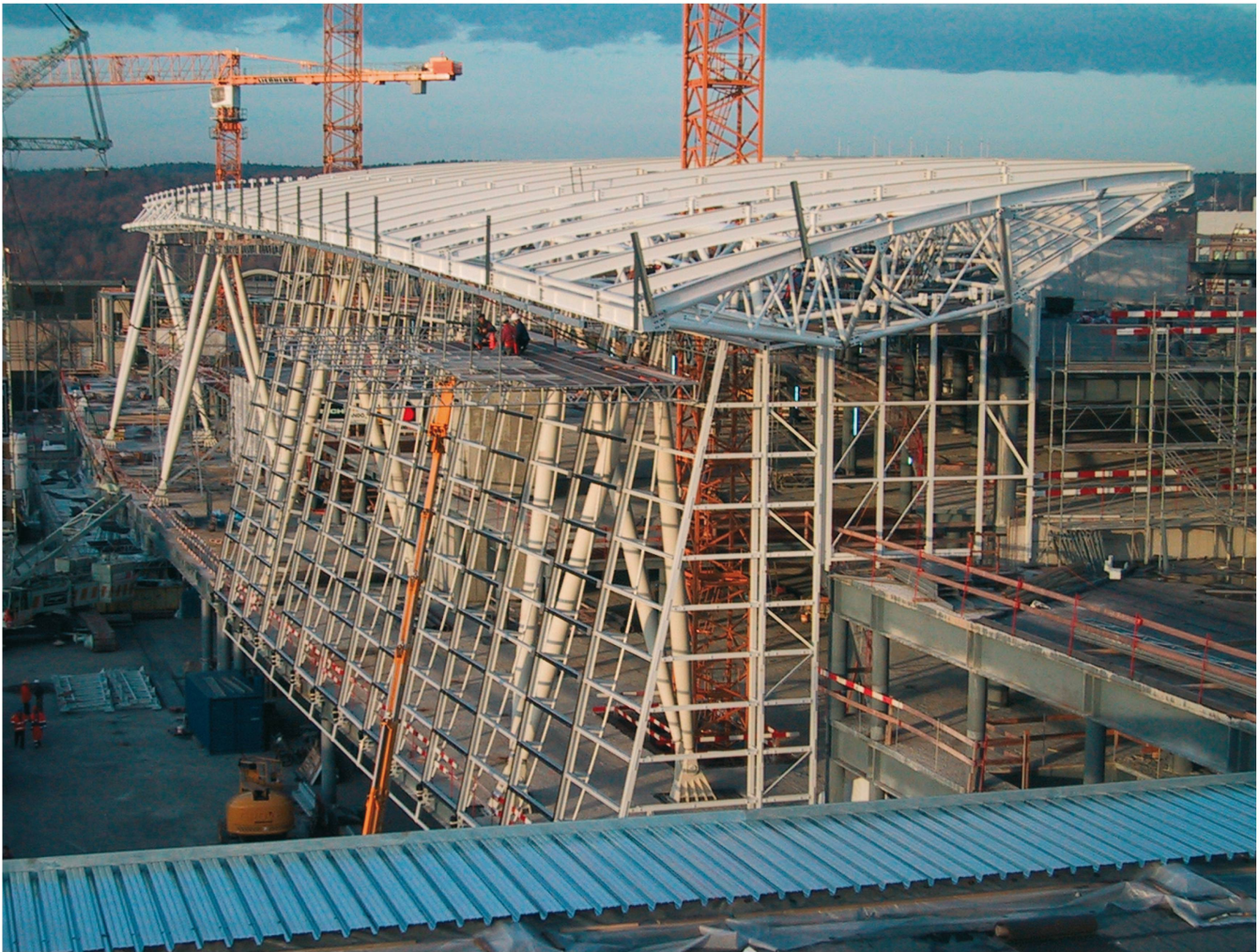
Dachkonstruktion für das Airside Center, Flughafen Zürich
