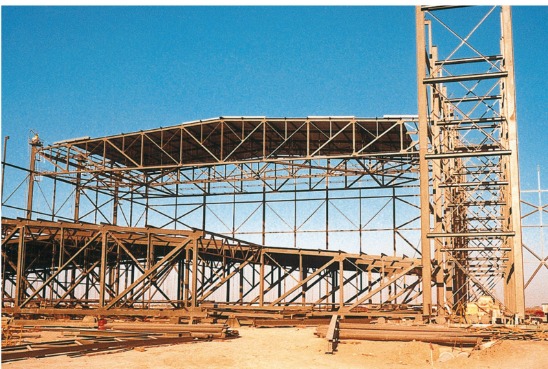
Stahlkonstruktion für Hangar des Flughafens in Bagdad
