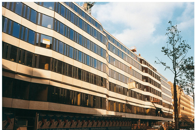
Geschäftshaus Storviggen in Stockholm
