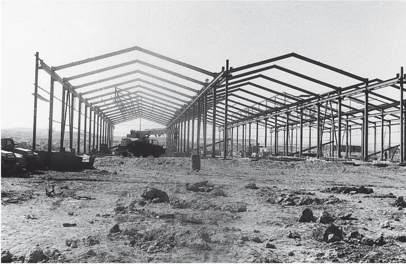
Hallenbau für die Firma Schindler in Kairo
