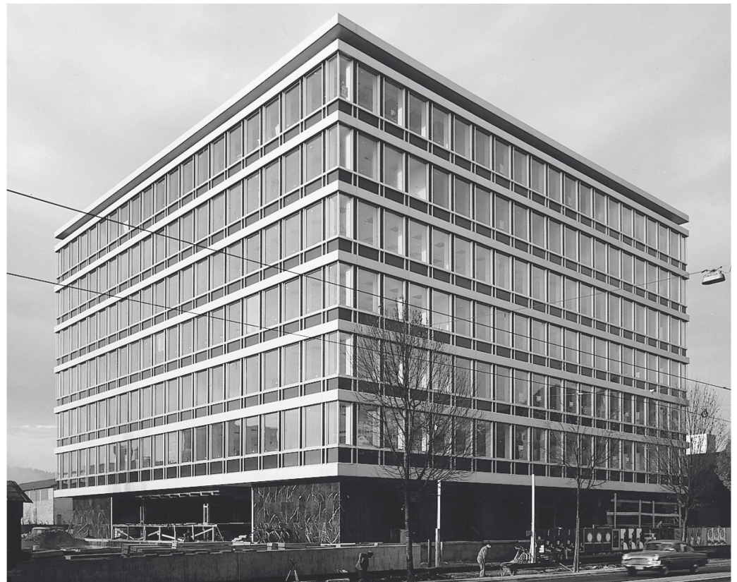
Verwaltungsgebäude Sais, Horn, 1963
