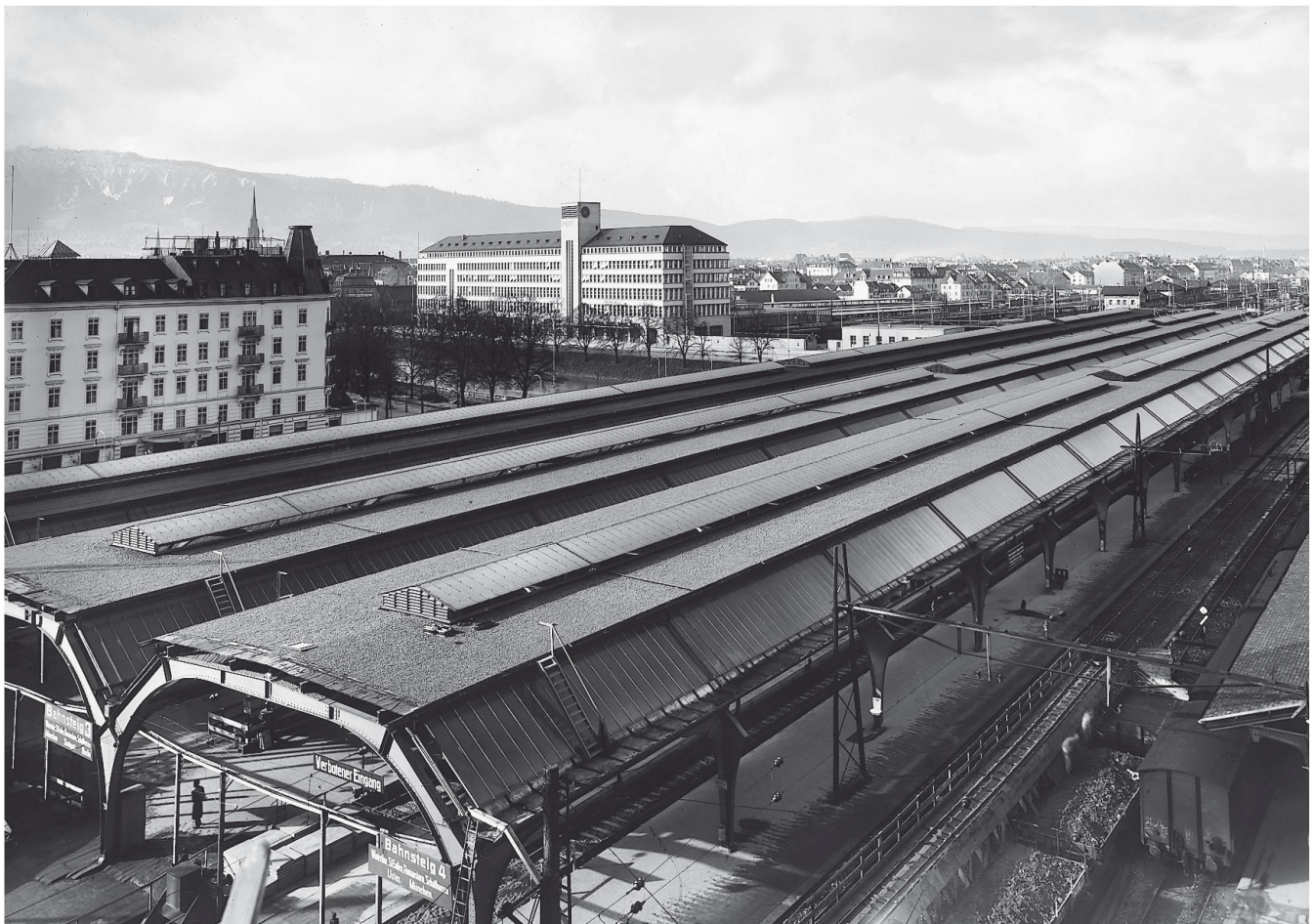
Glasdächer über den Perronhallen im Zürcher Hauptbahnhof
