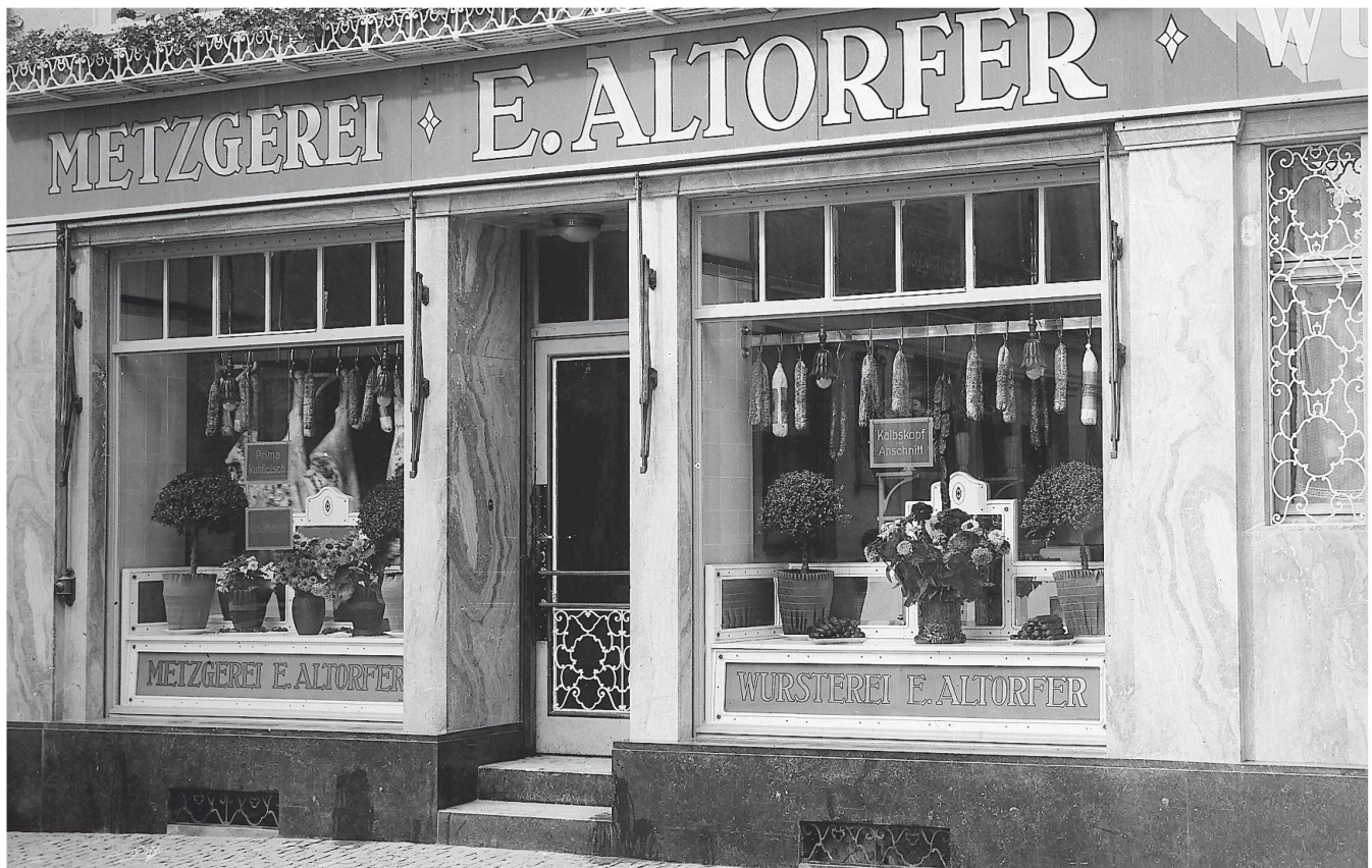
Schaufensteranlage mit neu entwickelten Aluminiumprofilen am Haus «Goldener Adler», Frauenfeld
