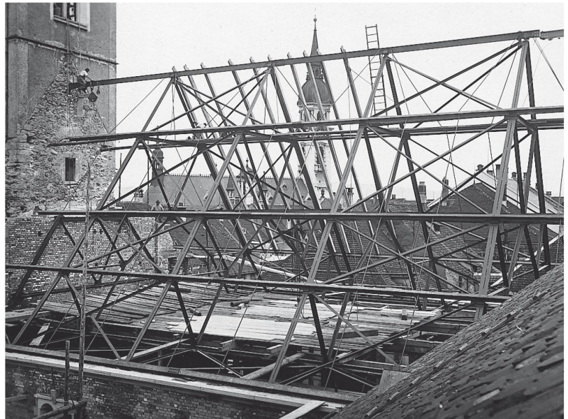
Montage der Dachkonstruktion an der evangelischen Kirche in Frauenfeld
