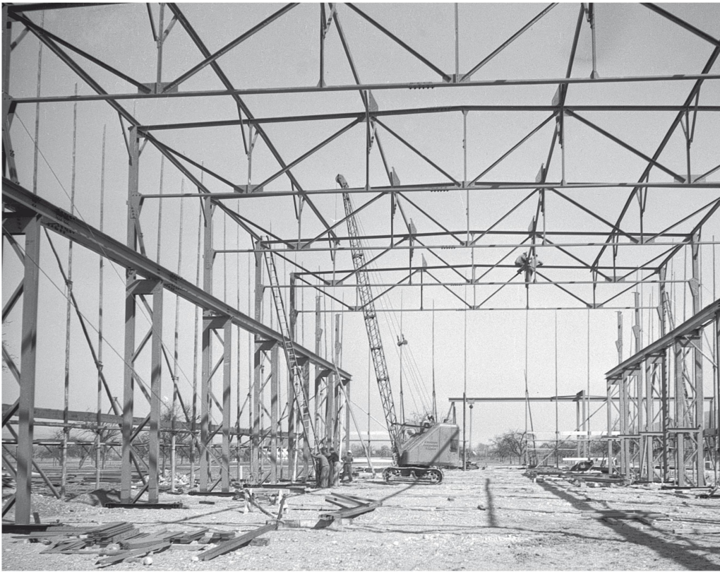
Errichtung der Stahlbauhalle im Frauenfelder Langdorf, 1949
