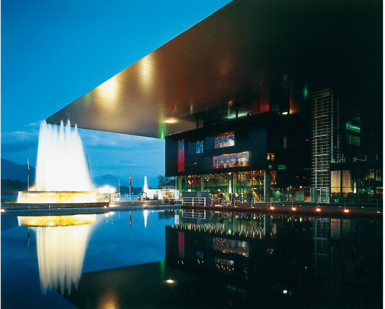
Eines der bedeutendsten Bauwerke von Tuschmid: das «Jahrhundertdach» des Kultur- und Kongresszentrums Luzern
