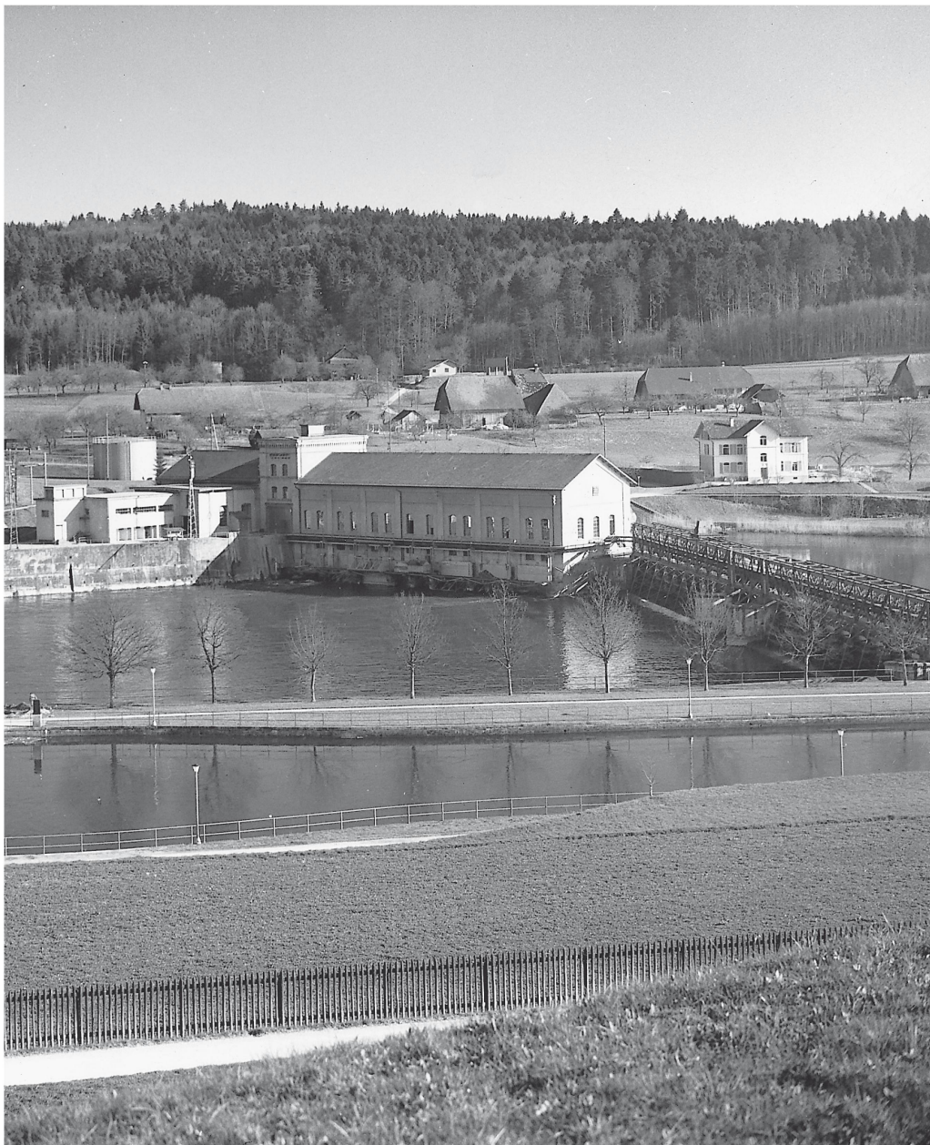
Das Kraftwerk Wynau der Elektrizitätswerke Wynau AG (heute onyx Energie Produktion) um 1960
