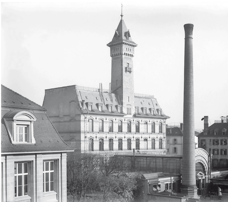
Das Maschinenlaboratorium kurz nach der Fertigstellung im Jahr 1900. Im Turm befindet sich das Wasserreservoir für hydraulische Versuche. Der Kamin im Vordergrund gehört zum Kesselhaus. (Bild ETH)
