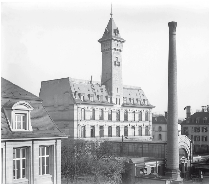
Das Maschinenlaboratorium kurz nach der Fertigstellung im Jahr 1900. Im Turm befindet sich das Wasserreservoir für hydraulische Versuche. Der Kamin im Vordergrund gehört zum Kesselhaus. (Bild ETH)
